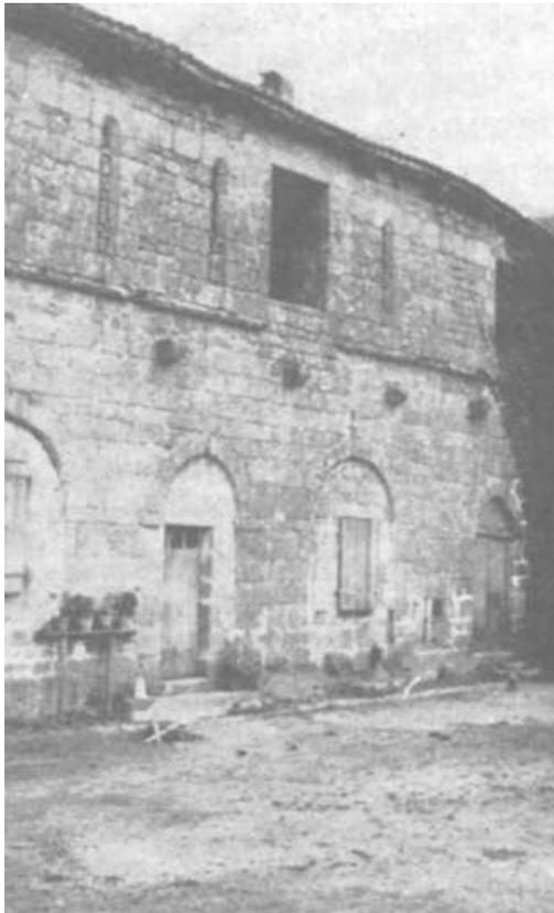
Ainsi amputée, la nef n'a plus intérieurement que 18 mètres de long, sur 6 mètres de large. Les murs ont 1.90m d'épaisseur.
