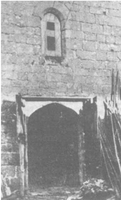
Sous chaque rencontre d'un compartiment de voûtes avec le mur (sauf à la façade) sont creusées de profondes arcatures en tiers point, sans moulure. Leur angle reste à 0.20m environ du sommet de la voûte. De *Verneilh* a voulu y voir des formerets. C'est une erreur. Un formeret est une nervure appliquée et non creusée dans le mur, exactement dans l'angle de la voûte. Rien de tel ici.
